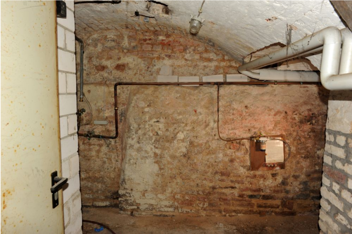
Forsthausstraße 34: ein Keller mit einer Einwölbung des 19. Jahrhunderts, aber deutlich älteren Außenmauern. (Foto: Ekkehard Kandler)
